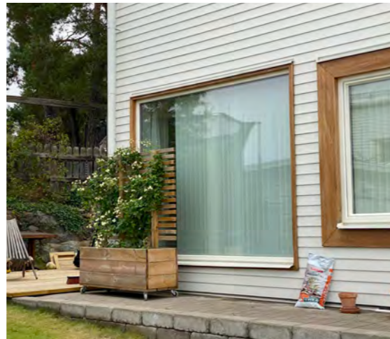
Ett spel med olika fönsterstorlekar och foder skapar samtida tolkningar av detaljen.
