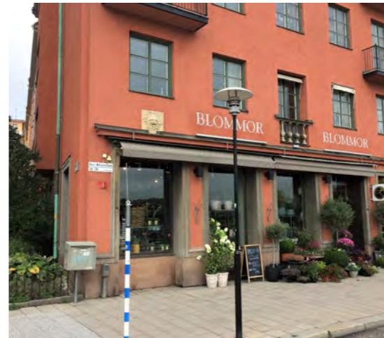
Urban fasad Bottenvåningen särskiljer sig tydligt från ovanliggande fasad med generös takhöjd och större glaspartier/entrépartier.
